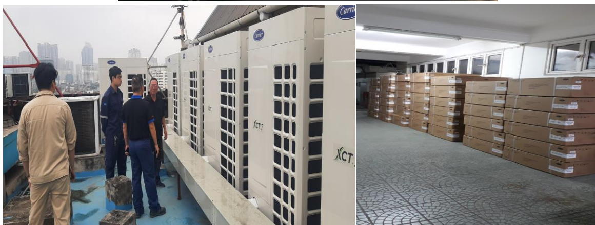
Cung cấp và lắp đặt hệ thống điều hòa thông gió – Tòa nhà VNPT Media – 57 Huỳnh Thúc Kháng – Đống Đa – Hà Nội
