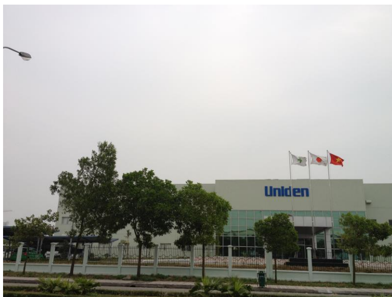
Công trình: cung cấp lắp đặt và bảo trì hệ thống điều hòa chiller – Công ty UNIDEN VIỆT NAM
