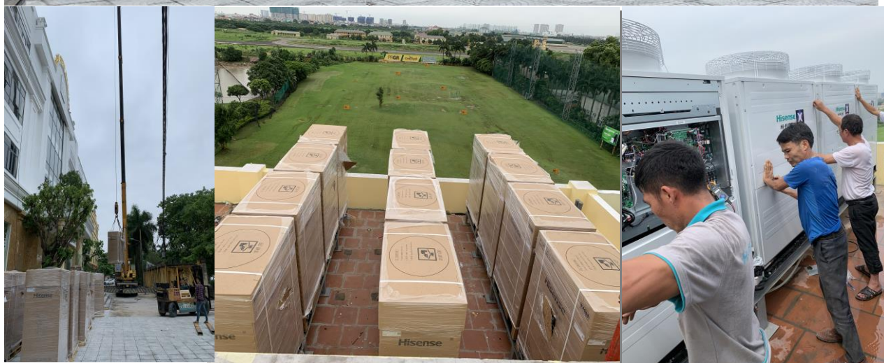
Công trình: Cung cấp và lắp đặt hệ thống điều hòa VRF Hisense/Hitachi cho tòa nhà dịch vụ Đào sen – 125 Nguyễn Sơn – Long Biên – Hà nội
