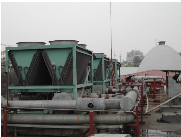
Công trình: Cung cấp lắp đặt hệ thống chiller – Cung văn hóa hữu nghị
