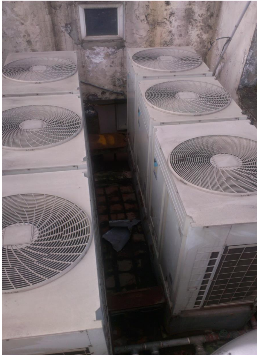
Công trình: Bảo trì, sửa chữa hệ thống điều hòa trung Daikin – VRV – II tại Cục quản lý lao động ngoài nước số 41B – Lý Thái Tổ - Hà Nội
